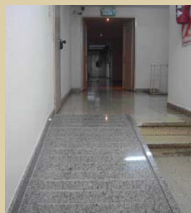
Acceso con rampa en el primer piso.
